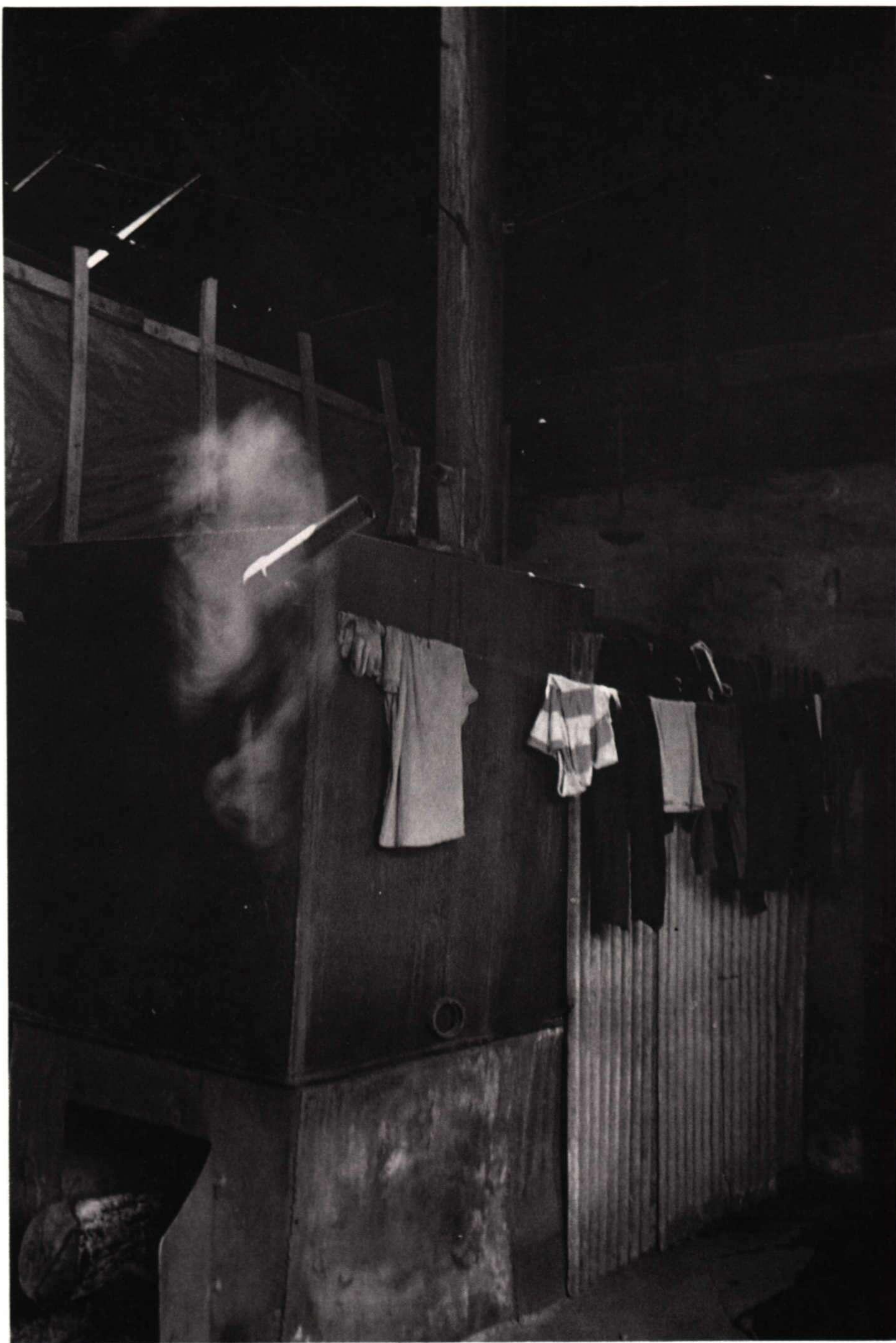
목욕탕 보일러실 - 한꺼번에 수백명씩 들어가 목욕을 하도록 현장에 지어진 현대식 목욕탕이 탄광마다 구비돼 있다. 그러나 쫄탁구덩이라고 불리는 영세탄광에는 갯목 쪼가리나 탄으로 물을 데워 전신에 묻은 탄을 씻는 이런 목욕탕 보일러실이 있었다.
